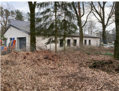
Bildtext 1: Hier startete EGE 1971: In einer ehemaligen Näherei im Verler Ortsteil Sende wurden die ersten Fenster per Hand verschweißt. Foto: EGE
