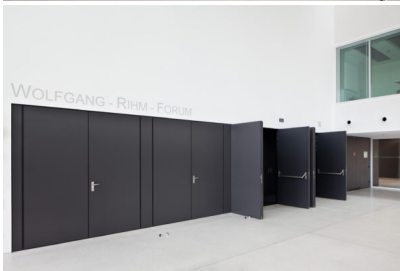
Bildtext 2: Dass Türblätter und Wand flächenbündig verschmelzen, ist dem verdeckt liegenden Band „Pivota DX 180 3D“ von BaSys zu verdanken. Foto: Daniel Vieser Architekturfotografie, Karlsruhe, www.dv-a.de
