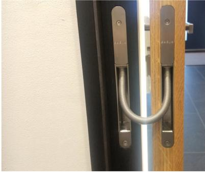
*Bildtext: Der Kabelübergang „Pivota Connect“ verschwindet in einer falzseitigen Fräsung und sichert die Energieversorgung zwischen Zarge und Türflügel – Voraussetzung, um die Tür mit zusätzlichen Sicherheits- und Komfortmerkmalen auszustatten. Foto: Basys*
