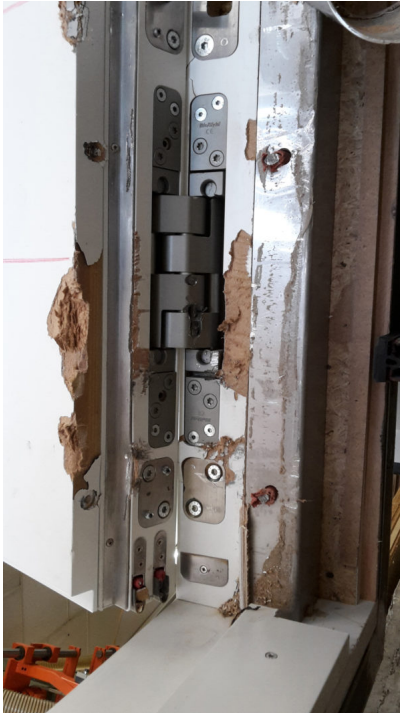
Bildtext 1: Das „Pivota DXS 300 Steel“ weist eine Tragfähigkeit von 350 Kilogramm pro Paar auf und besteht ausschließlich aus Stahl. Dadurch erreicht das Band die Einbruchhemmung der Widerstandsklasse RC4. Das Bild zeigt das Band nach bestandener Einbruchprüfung. Foto: Huber Form Schreinerei GmbH, Triftern-Neukirchen
