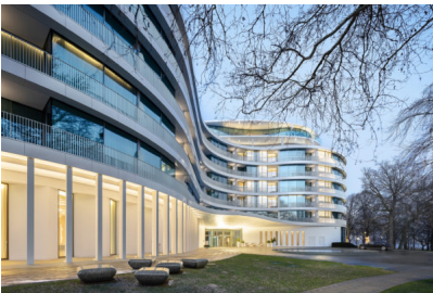
Bildtext 5: Bandsysteme von Basys unterstützen das architektonische Gesamtkonzept des Hamburger Grandhotel „The Fontenay“ mit Design und Funktion. Foto: Daniel Wieser Architekturfotografie, Karlsruhe, www.dv-a.de
