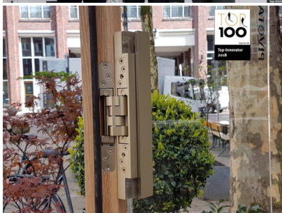
Bildtext 2: Schon 2001 hatte BaSys mit der „Pivota DX“-Produktfamilie als erster deutscher Hersteller ein verdeckt liegendes und dreidimensional justierbares Band vorgestellt. Mit der neuesten Entwicklung „Pivota DX Glass“ adaptiert BaSys diese bewährte Technik auf die Anwendung an Ganzglastüren – mit entsprechenden Vorteilen für die Skalierbarkeit der Tragfähigkeit, die CE-Zertifizierung sowie den Einsatz in Standard-zargen. Die Komponenten des objektgeeigneten Beschlagsystems sind im Design fein aufeinander abgestimmt und schließen flächenbündig mit dem Zargenspiegel ab. Für die Organisation seiner innovativen Prozesse im Unternehmen erhielt BaSys jetzt die Auszeichnung als TOP 100 Innovator 2018. Foto: BaSys
