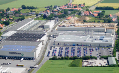
Bildtext 1: Am 1. Juli 2017 ging am Standort Bad Essen mit der Erweiterung und Modernisierung eine der modernsten Galvanikanlagen Europas in den Testbetrieb (das vordere Gebäude im rechten Bildteil hinter dem Parkplatz). Zukunftsweisende Technologien ermöglichen es, die Produkte mit neuen dekorativen und widerstandsfähigen Oberflächen zu versehen. Foto: Kesseböhmer
