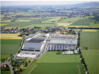
Bildtext 1: Luftbild Baustelle bei Kesseböhmer in Dahlinghausen. Foto: Kesseböhmer
