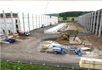
Bildtext 3: Baustelle bei Kesseböhmer in Dahlinghausen. Gut erkennbar: der sieben Meter tiefe und 150 Meter lange Stanzenkeller. Foto: Kesseböhmer
