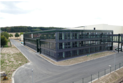
Bildtext 6: Das neue Bürogebäude bei Kesseböhmer in Dahlinghausen. Foto: Kesseböhmer
