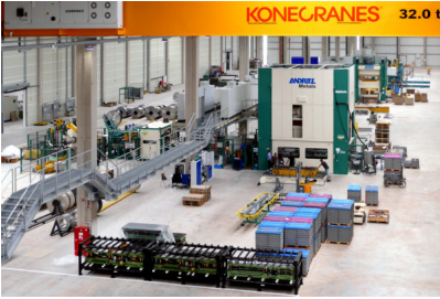
Bildtext 5: Das neue Stanzenpresswerk bei Kesseböhmer in Dahlinghausen. Foto: Kesseböhmer
