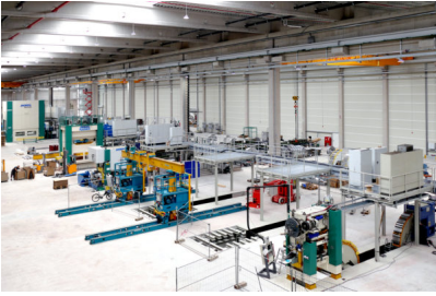
Bildtext 4: Das neue Stanzenpresswerk bei Kesseböhmer in Dahlinghausen. Foto: Kesseböhmer
