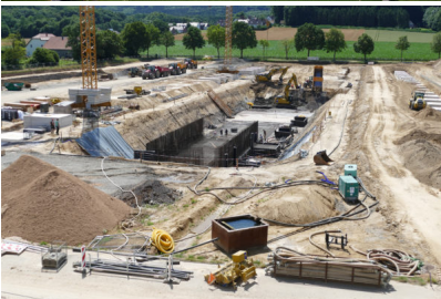
Bildtext 2: Baustelle bei Kesseböhmer in Dahlinghausen. Foto: Kesseböhmer
