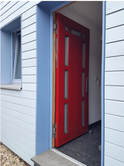
Bildtext 5: Das moderne Design der Baubeschläge spielt eine große Rolle bei Haustüren, die in der Tischlerei Holtkamp als „Visitenkarte des Hauses“ gelten. Hier kommt das verdeckt liegende „Masterband FX2“ für überfälzte Haustüren zum Einsatz. Foto: Basys
