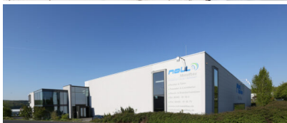
Bildtext 2: Schüco-Verarbeiter seit 1972: Noll in Görgeshausen entwickelt mit rund 60 Mitarbeitern Lösungen für die Gebäudehülle und deckt dank des Systemgebers alle Anforderungen an den Brand-, Wind-, Schall- und Einbruchschutz ab. Foto: Noll
