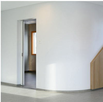
Bildtext 2: Die Räume der isländischen Spielschule sollten bei geöffneten Türen fließend ineinander übergehen. Darum kamen Schiebetüren zum Einsatz. Foto: Marino Thorlacius
