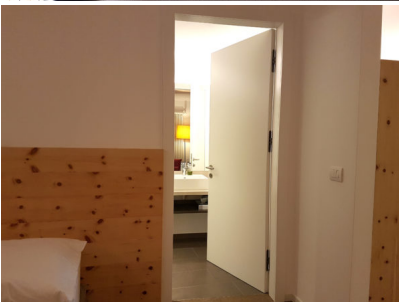
Bildtext 3: Wie die Zwischentüren sind die Badezimmertüren mit dem „Pivota DX38“ für 60 Kilogramm schwere Türen verbaut. Das Band kommt im Hotel „Cristal“ insgesamt 250 Mal zum Einsatz. Foto: BaSys
