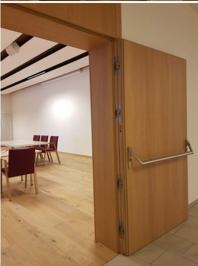
Bildtext 4: Die Spezialtüren für die Konferenzräume wurden mit besonderen Anforderungen an den Schallschutz entwickelt. Foto: BaSys
