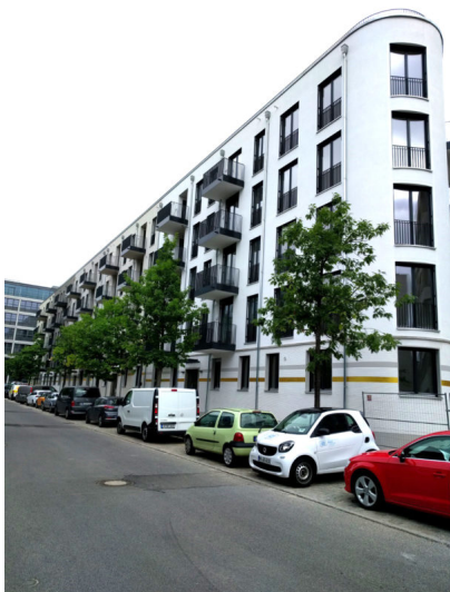
Bildtext 5: Ein Wohnungsbauprojekt in der Englischen Straße in Berlin. Innerhalb von acht Monaten montierte die EGE Holzbau GmbH hier 1.557 Holzfenster, darunter 1.200 in RC2 und 200 in RC3. Foto: EGE Holzbau
