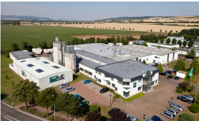
Bildtext 1 (3): Die EGE Holzbau in Sangerhausen. Foto: EGE
