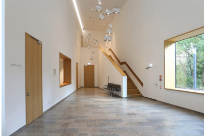
Bildtext 3: Sämtliche Innentüren in der Tauberphilharmonie Weikersheim sind stumpf ausgeführt, so dass das Türblatt bündig und harmonisch mit Zarge und Wand abschließt. Verdeckt liegende Bänder nehmen sich dezent zurück und lassen das großflächige Türendesign für sich wirken. Foto: Michael Meschede, Kaufungen
