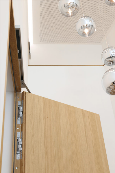
Bildtext 4 a – c: Bei Brandschutztüren in Übergrößen setzte Neuform in der Tauberphilharmonie Weikersheim auf das verdeckt liegende Band „Pivota DX 300 3-D“ von Basys. Es weist eine Tragfähigkeit von 300 Kilogramm pro Paar auf, ist wartungsfrei gelagert und lässt sich dreidimensional justieren. Foto: Michael Meschede, Kaufungen
